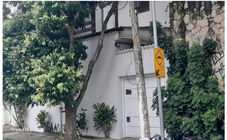
Foto da Fachada do Imóvel
