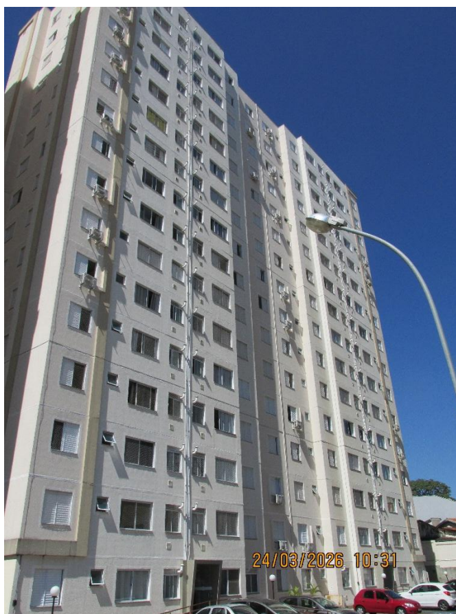
Fachada do Bloco
