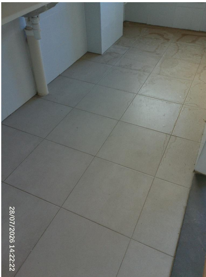
Cozinha/Area de Serviço/Piso
