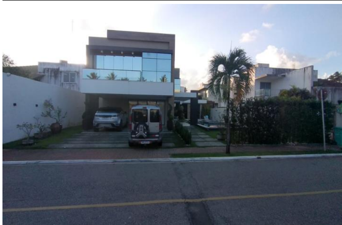
Fachada do avaliando
