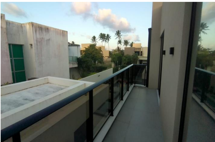
Varanda 2 - 1º Pavimento
