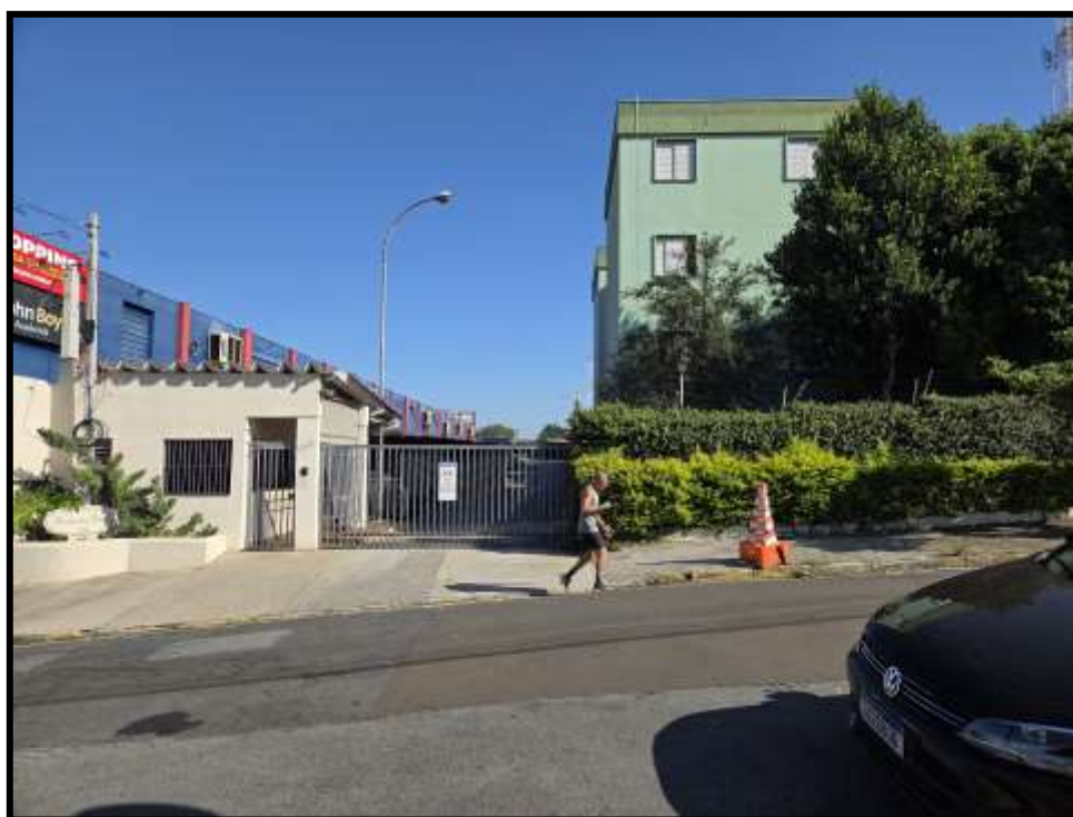
3. VISTA GERAL DO CONDOMÍNIO.
