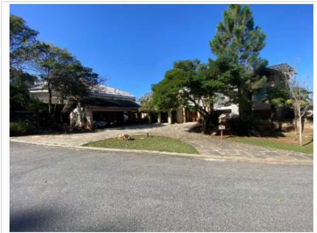
Fachada do imóvel - vista 1
