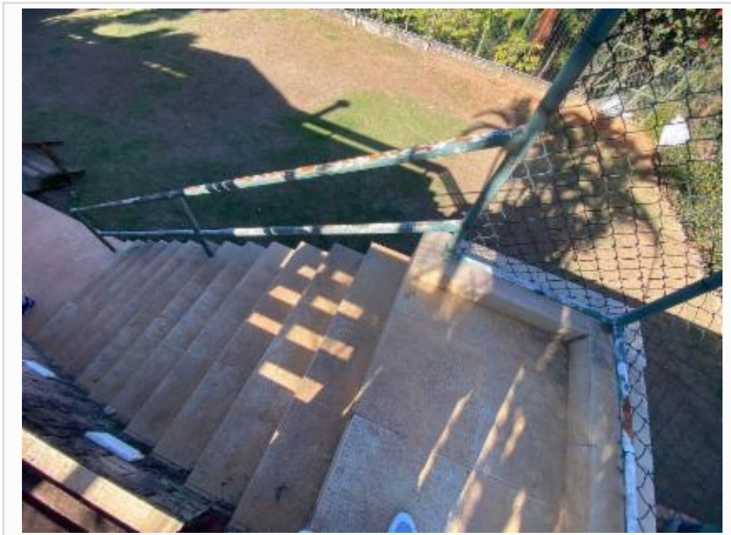
Acesso as áreas dos fundos - vista 1
