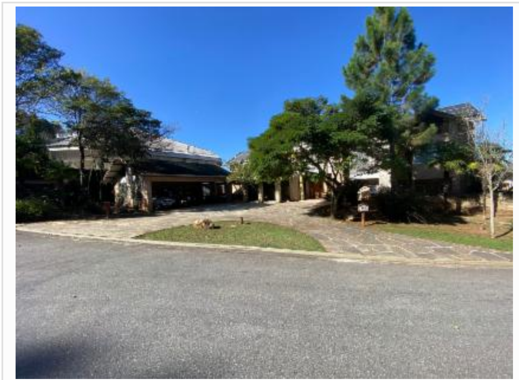
Fachada do imóvel - vista 1
