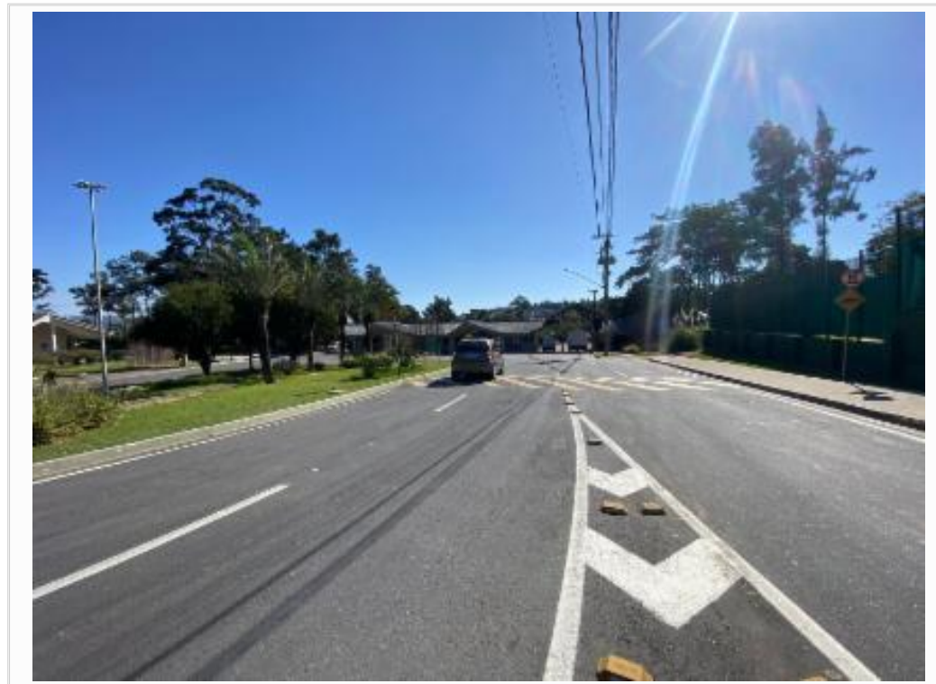
Fachada do condomínio - vista 1
