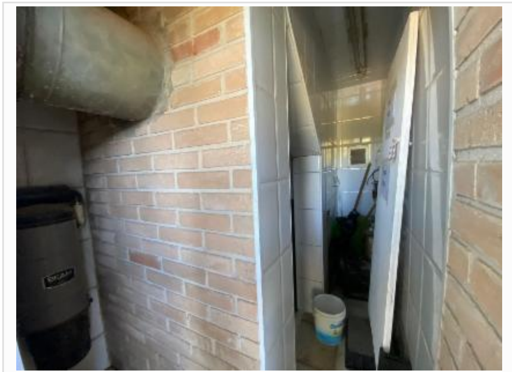
Casa de maquinas 1 - vista 1
