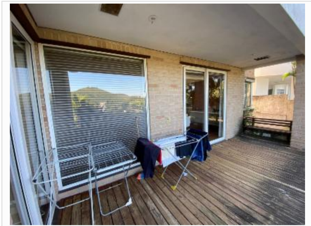
Varanda coberta - vista 2
