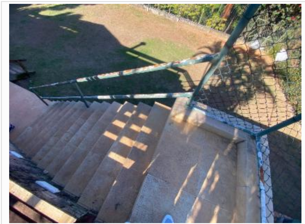
Acesso as áreas dos fundos - vista 1
