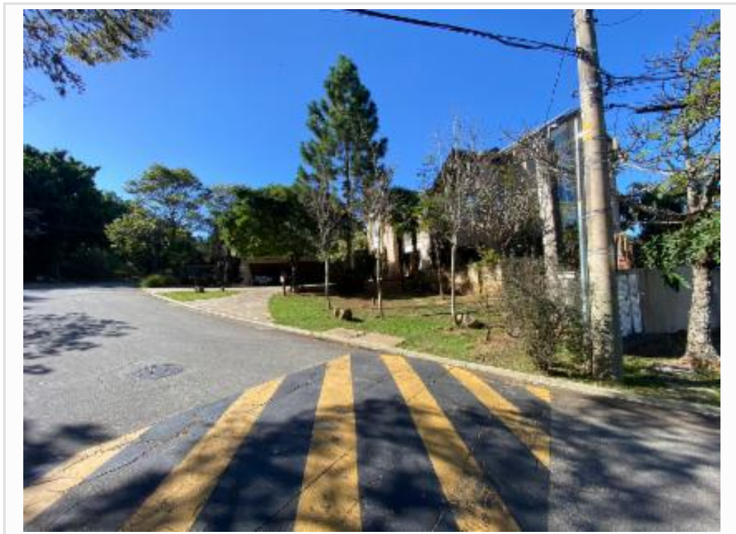
Fachada do imóvel - vista 2
