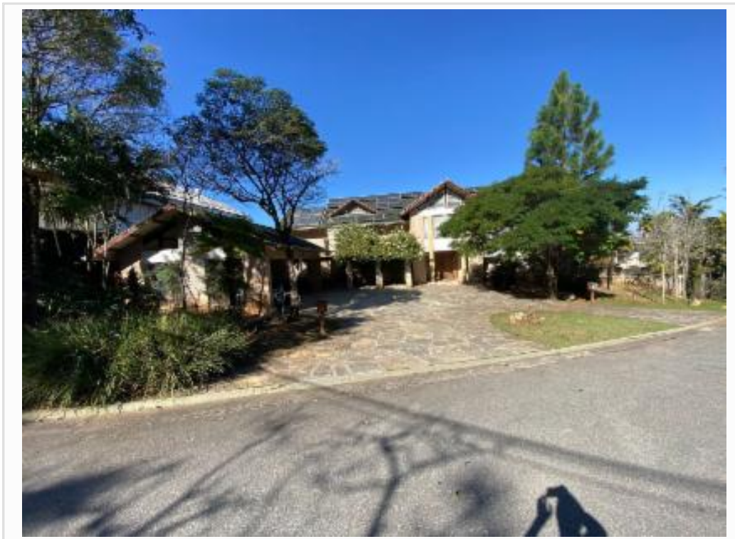
Fachada do imóvel - vista 3
