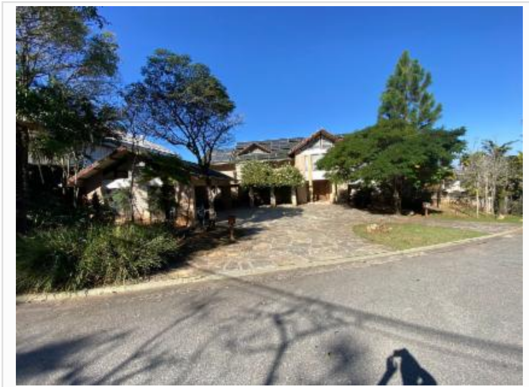
Fachada do imóvel - vista 3
