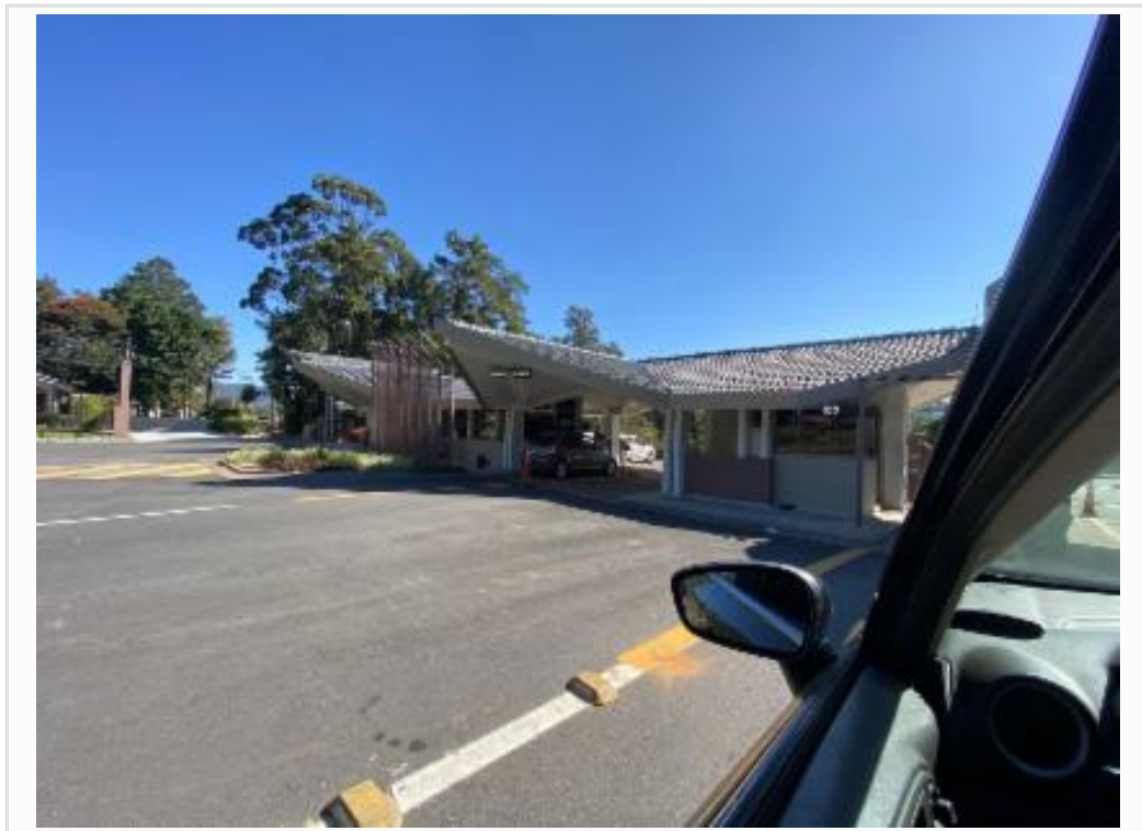
Fachada do condomínio - vista 2
